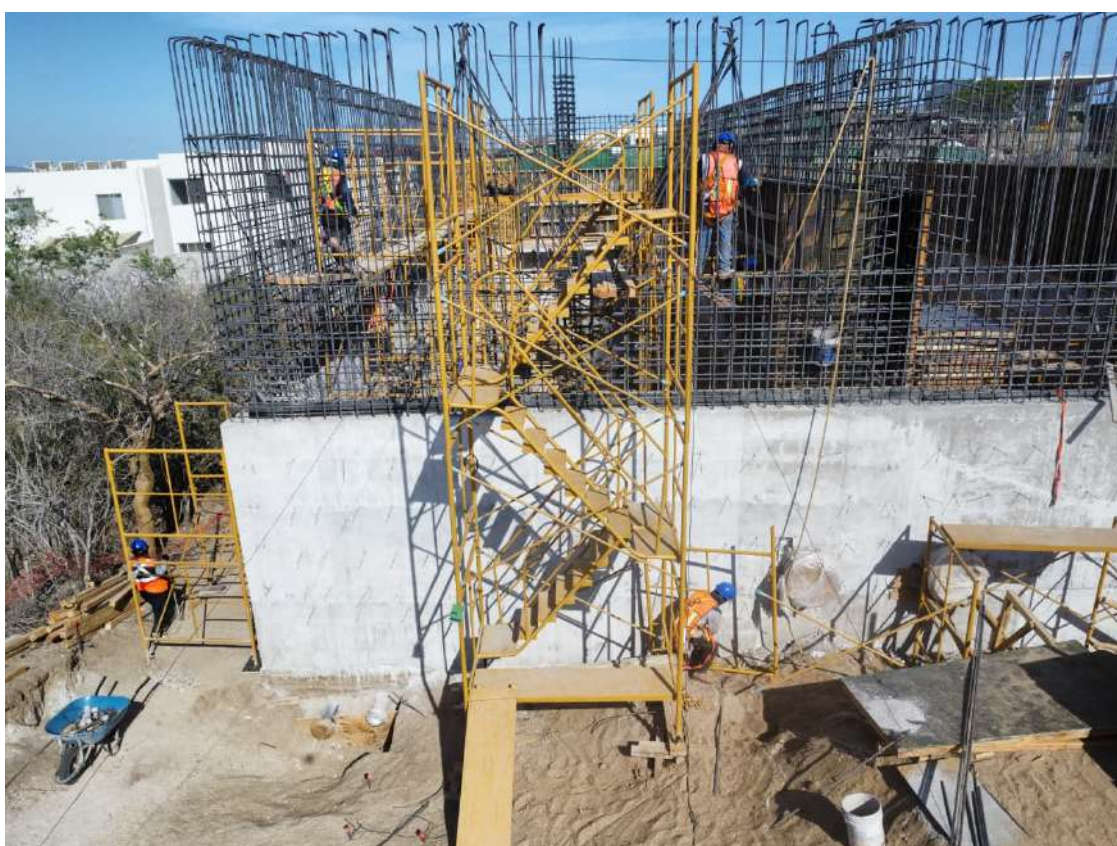
En la Planta Desaladora se realizaron los colados de la Plantilla de remineralización, así como de la Canaleta y Bases, acciones fundamentales para el proceso de potabilización del agua de mar.
