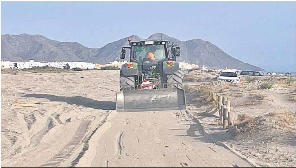
Maquinaria este verano reponiendo el camino de acceso a la playa de El Charco, en Cabo de Gata.
